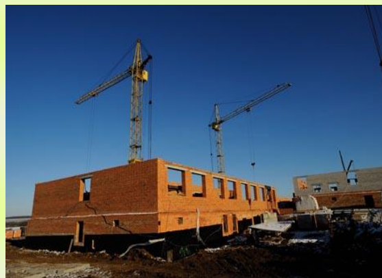
Строительство комплекса школа-детский сад в с.Губарево 130,4 млн. рублей
